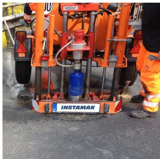
Die seit vielen Jahren bekannten und bei der dauerhaften Sanierung von Schlaglöchern und Deckschichtabplatzungen bewährten Reparaturasphalte von INSTAMAK wurden schon 2009 um die Körnung 0/16 als Trag-/Deckschicht ergänzt.
