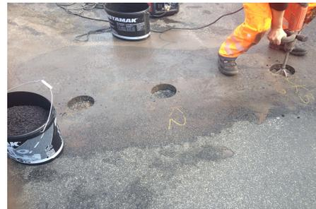
Zunächst wird direkt nach der Bohrkernentnahme die Binderschicht mit Körnung 0/16 oder 0/11 in Lagen von ca. bis zu 60 mm verfüllt und mittels eines runden Stampfers maschinell verdichtet. Die oberen 40 mm (Deckschicht) werden dann frisch in frisch mit Körnung 0/8 eingebaut und ebenfalls verdichtet, so dass eine leichte Überhöhung vorhanden ist.
